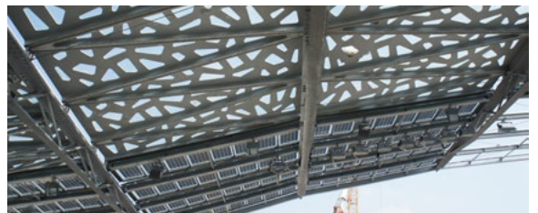
Rénovation du stade Jean Bouin, Paris (ACI Excellence Award 2015), mise en œuvre d'un BFUP, matériau nouveau au service du renouvellement de la ville © François Toutlemonde / IFSTTAR
