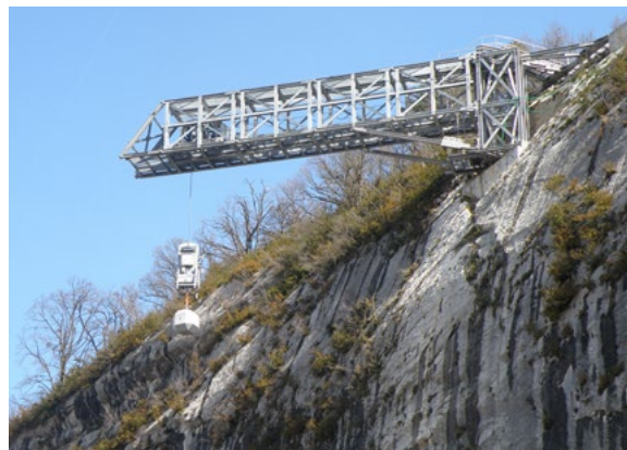
Station expérimentale de chute de blocs de l'Ifsttar à Montagnole (73) © Marion Bost / IFSTTAR
